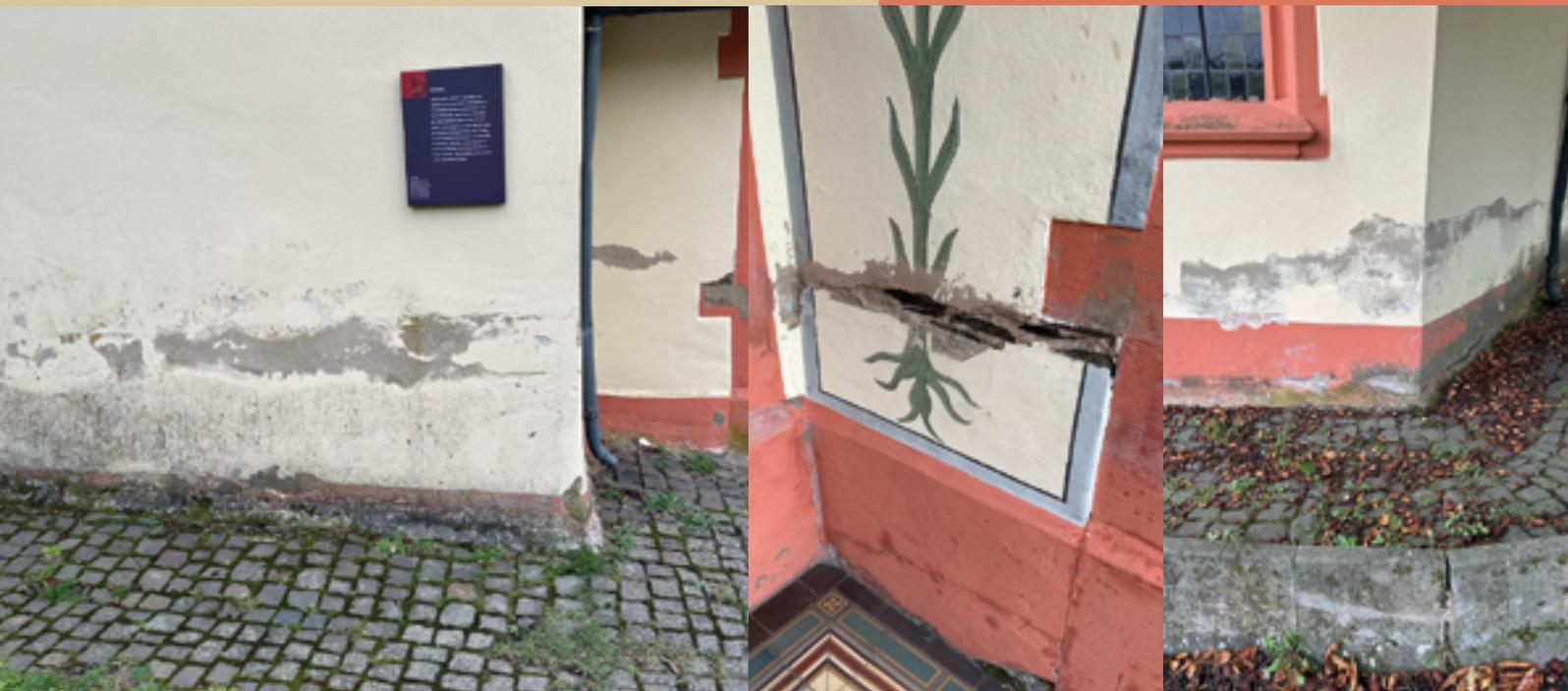
Sanierung der mit Salpetersalzen durchzogenen Putzflächen durch ein Sanierputzsystem
